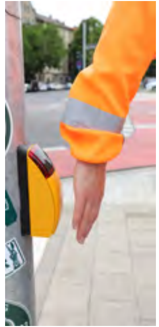
Der Radartaster funktioniert kontaktlos.
