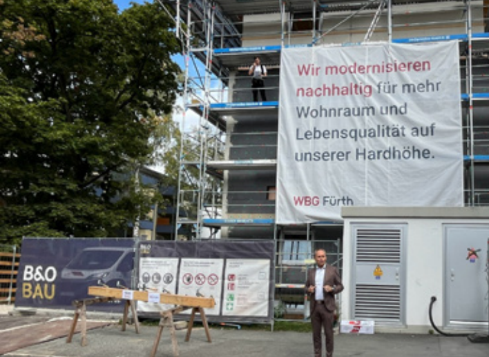
Ein wichtiger Schritt für die Modernisierung auf der Hardhöhe: WBG-Geschäftsführer Rolf Perlhofer betonte beim Richtfest: „Die Leibnizstraße zeigt, wie wir diese Zielsetzung Schritt für Schritt in unserem Bestand umsetzen.“
